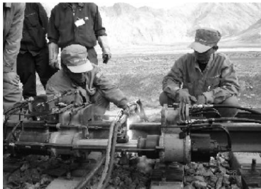
图 1 数控移动式钢轨气压焊在青藏铁路现场焊接
