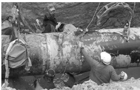
图 2 水网施工现场
