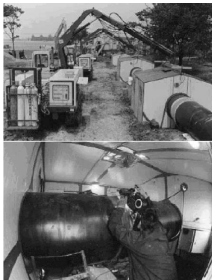
图1 全自动焊接施工现场
