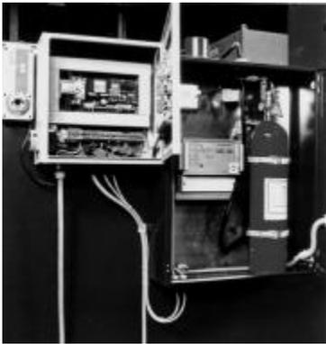
图 8 安装在除尘器外壳的全自动火花监测和灭火系统
