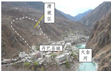
图 13 丹巴滑坡 Fig.13 Danba landslide
