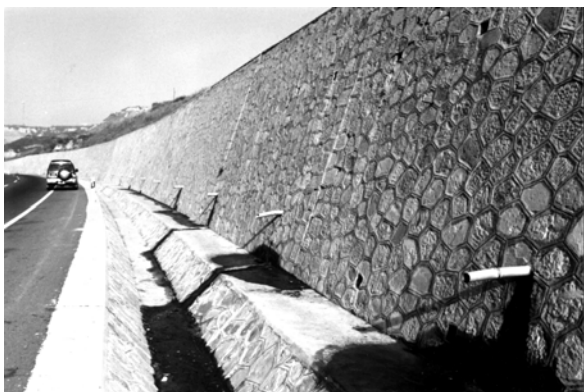
图 40 冯家河滑坡的仰斜排水孔
