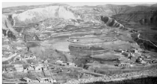
图 21 陕西铜川某地黄土滑坡(滑床为砂泥岩的顶面)
