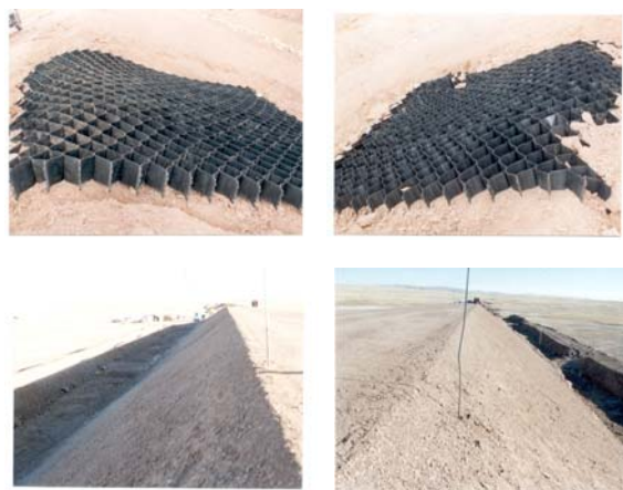
图2 土工格室铺设图片
