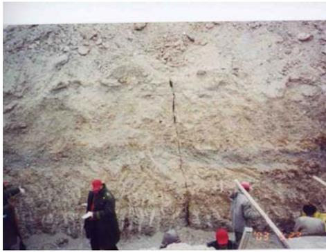
图3 DK1026+630 断面纵向裂缝贯通路基本体
