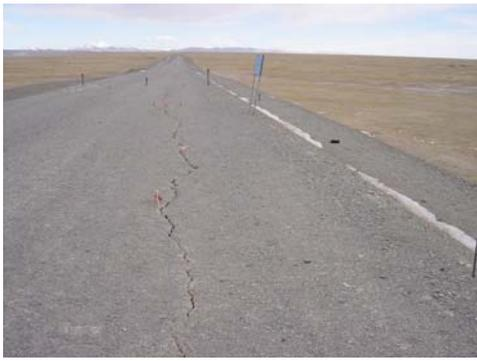
图1 DK1026+590~DK1026+684 路基表面纵向裂缝
