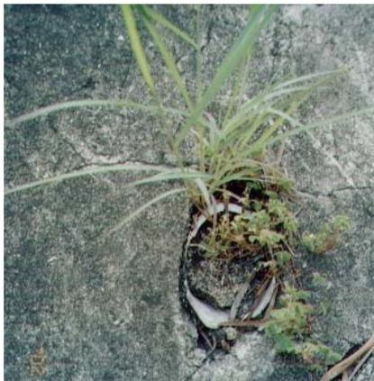
图 1 边坡排水孔被堵塞并在孔口长草的情形
