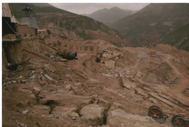
图 2 海石湾煤矿上工业广场滑坡
