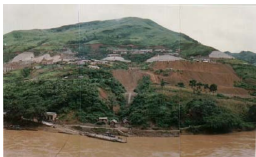
图 1 八渡滑坡全貌
