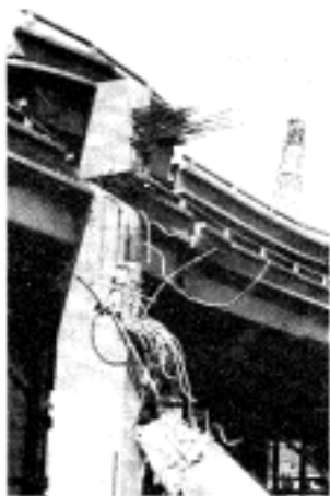
图 13 钢筋从支撑中拔出
