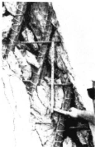
图 14 如细钢丝的箍筋
