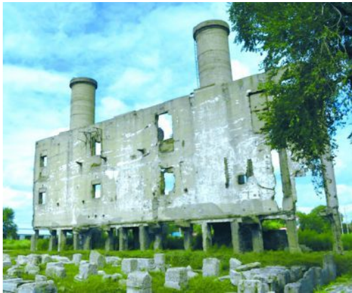
侵华日军731部队罪证陈列馆内锅炉房遗址。
