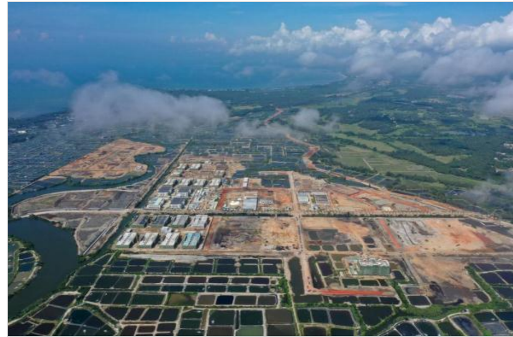
图为建设中的冯家湾现代化渔业产业园。(无人机照片) 新华社记者郭程 摄
