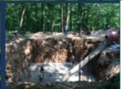
开挖地基施工现场
