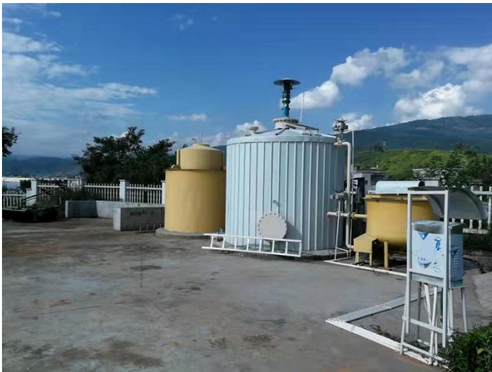
30m 3 烟草秸秆沼气发酵装置
