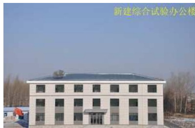
新建综合试验办公楼
