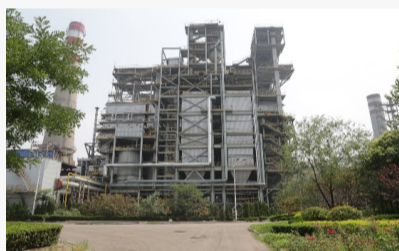
邯钢烧结烟气超低排放示范
