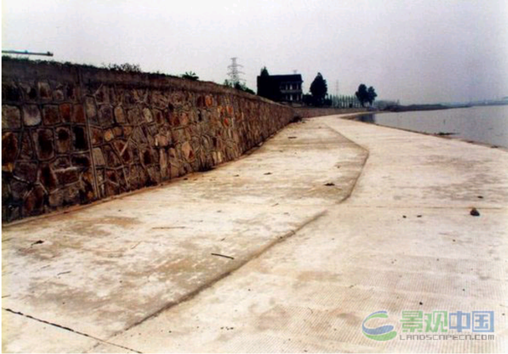
图02 公园场地现状：硬化的防洪堤
