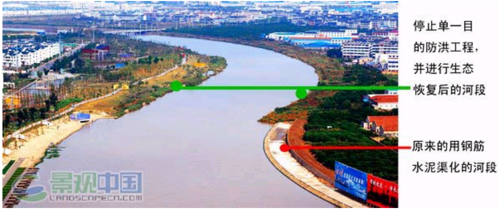
图01 水泥硬化和渠化的永宁江段（由侧下半部）与生态保育和恢复后的永宁江段（上半部分，左侧为永宁公园）的对比。
