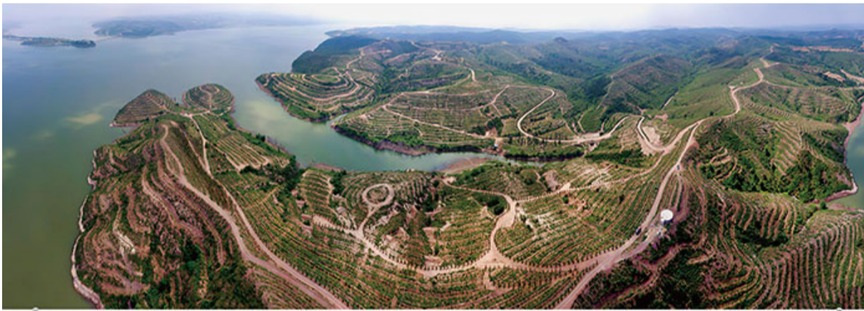
河北省承德市围场满族蒙古族自治县综合治理工程，有效减少泥沙入河，保障防洪安全
