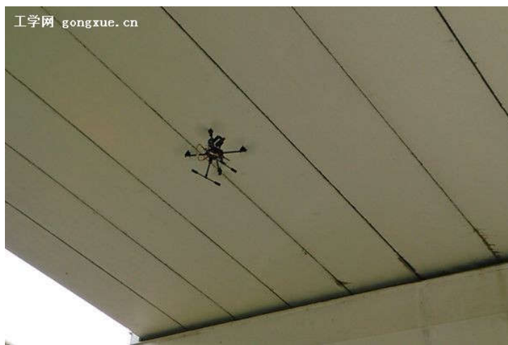
无人机样机在桥下进行检测
