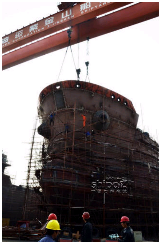
25000T-4#油轮正在进行船艙甲板与船体的定位合拢施工
