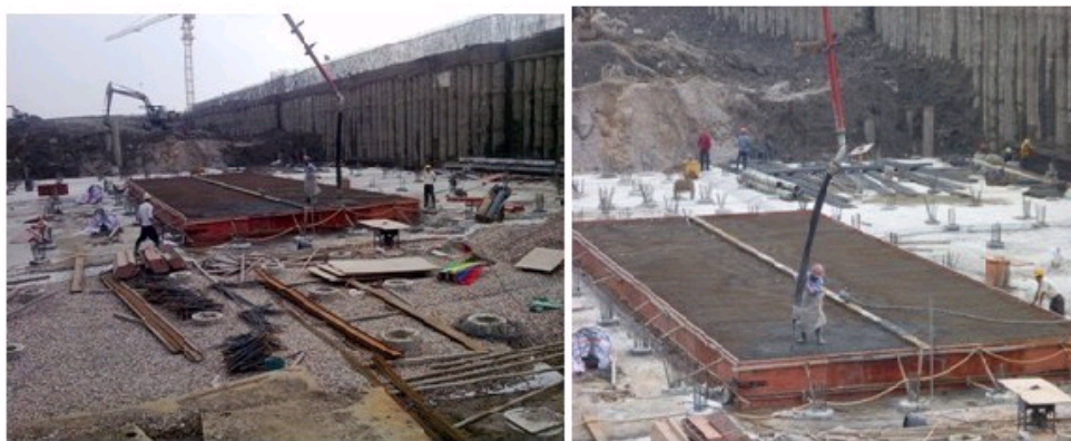
图: 船坞浇筑第一块坞室底板混凝土
