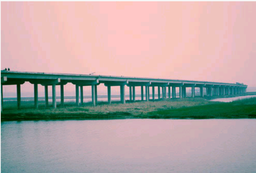
建设中的淮金公路
