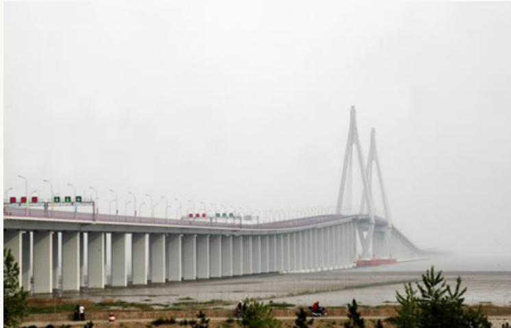
2008年4月30日，杭州湾跨海大桥。
