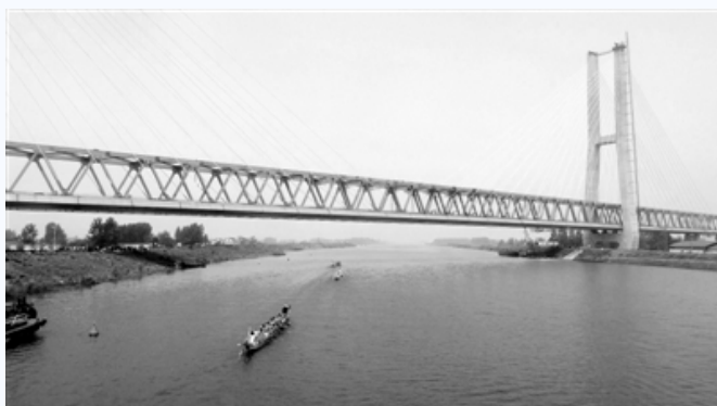
裕溪河特大桥受访者供图
