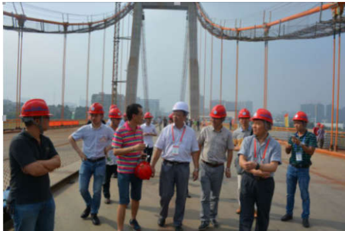
代表参观株洲枫溪大桥轻型组合桥面施工现场
