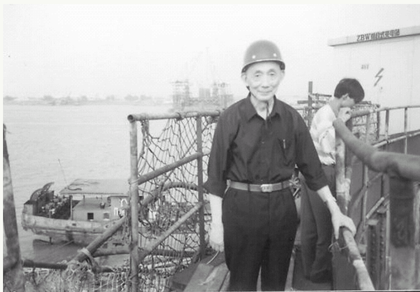
1992年方秦汉在九江长江大桥工地讨论施工问题。
