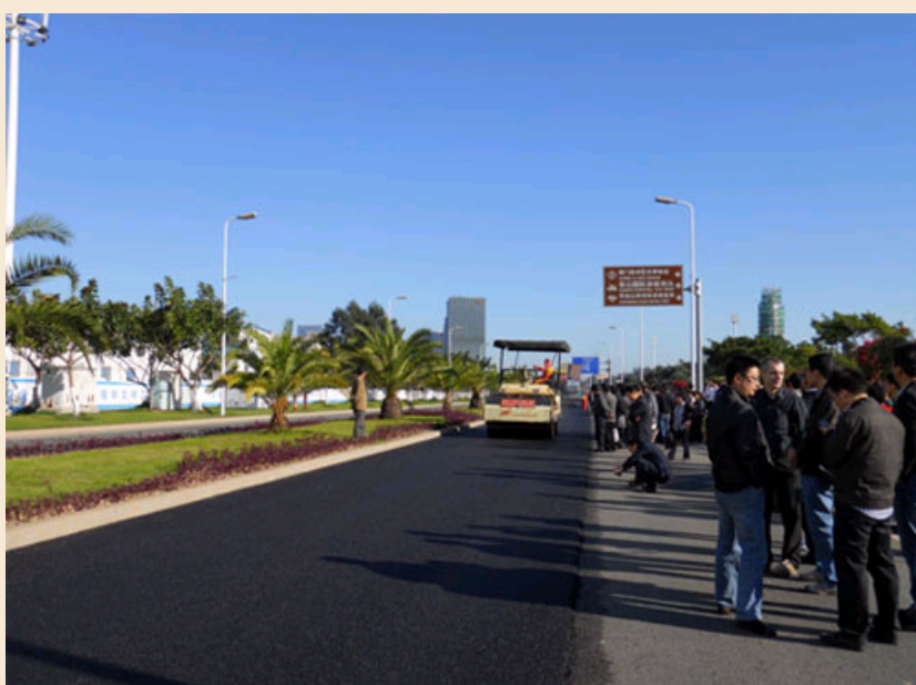
与会代表参观超薄磨耗层摊铺现场
