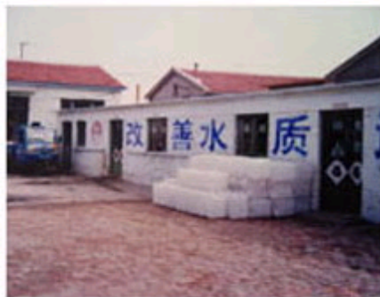
咸水淡化站厂房、储水箱
