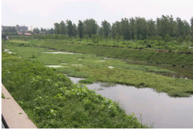
漫泗河多自然型河道示范工程
