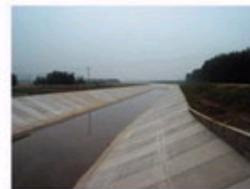
机械化衬砌的渠道
