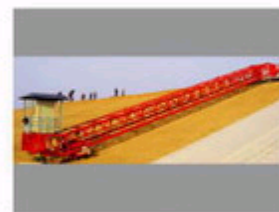
施工中的渠道衬砌机
