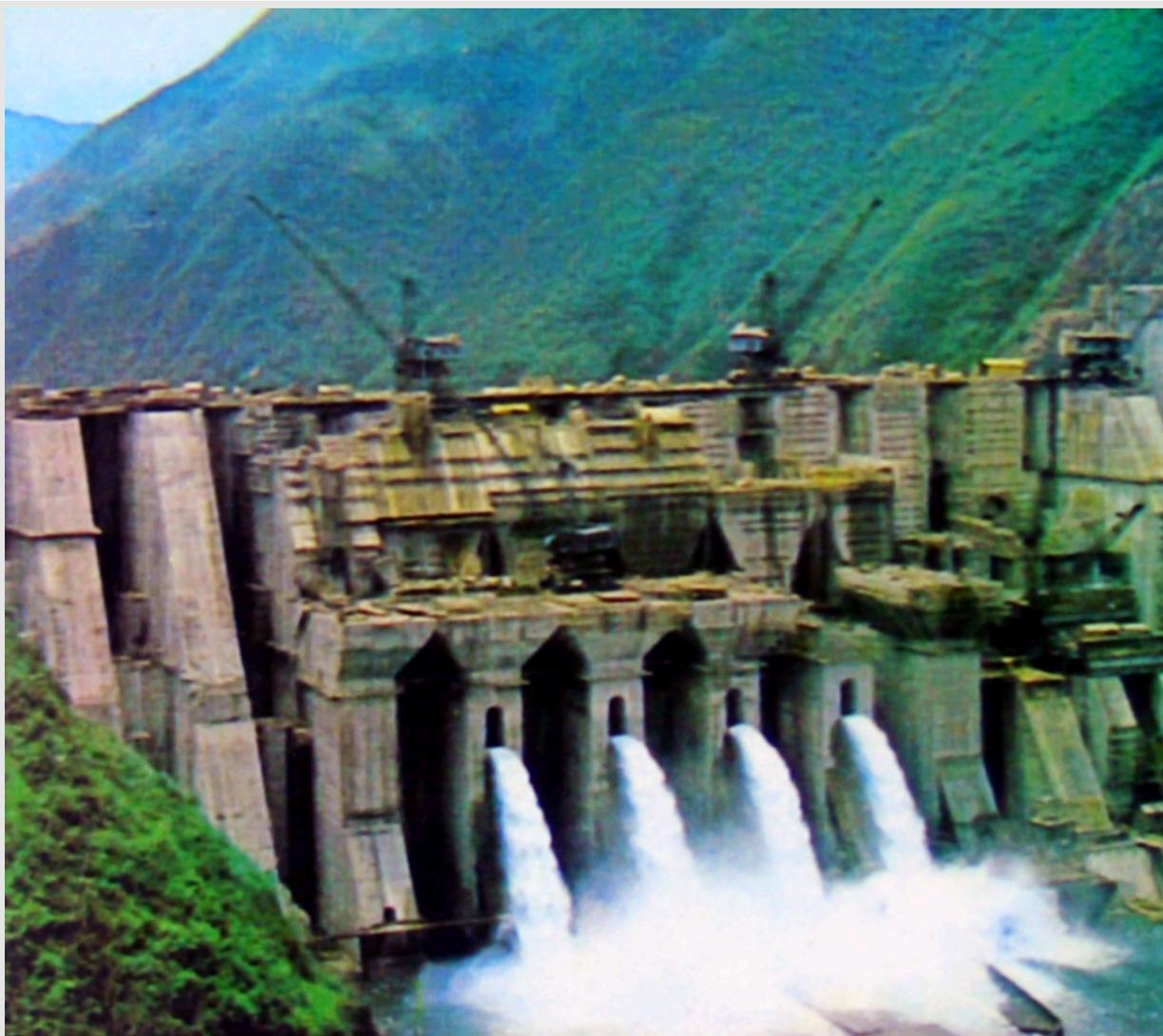
湖南镇水电站位于中国浙江省衢州市境内、钱塘江支流乌溪江上，是继新安江、富春江水电站后浙江省建成的又一较大水电站。以发电为主，兼有防洪、灌溉、航运、供水等综合利用效益。是乌溪江两级开发中的第一级水电站，第二级为黄坛口水电站。电站于1958年开工，1962年停工缓建。1970年复工，1979年第1台机组发电，1980年10月4台机组全部并网投产。拦河坝为混凝土梯形支墩坝，最大坝高129m，电站装机17万kW。水库淹没耕地8000hm<sup>2</sup>，移民2.36万人。为提高华东电网的调峰能力，充分发挥水能资源，1994年12月扩容工程开工。利用已预埋在5号坝段的引水钢管，扩容1台单机10万kW的水轮发电机组，扩大后总装机容量增加至27万kW。1996年10月扩建工程完成。
