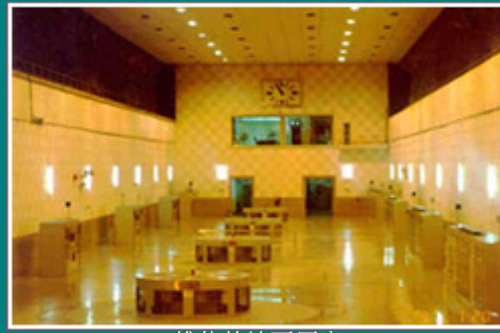
雄伟的地下厂房
