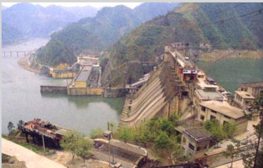
柘溪水电站位于中国湖南省、资水干流上，距安化县东平市12.5km。混凝土单支墩大头坝，最大坝高104m，装机容量44.7万kW，保证出力11.27万kW，多年平均发电量21.74亿kW·h。工程以发电为主，兼有防洪、航运等效益。1958年7月开工，1962年1月第一台机组发电，1973年12月全部投产。
