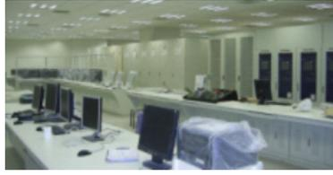
设置防灾控制中心（含应急指挥中心、消防控制中心），解决大楼的消防、安保、监控、漏电火灾报警、漏水检测系统、超高层的震动测量装置、电能管理系统等设备的集中设置及管理问题；防灾中心设置在1F层裙房内，面积在250平方米以上，对外有直接出口，门口有明显的标志。
