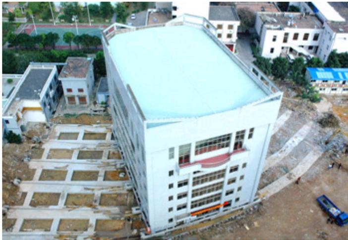
12月3日上午10时30分，由建研抗震工程技术有限公司承担，与建研科技股份有限公司合作进行的厦门市人民检察院综合楼整体平移工程顺利完工。该建筑物整体准确平移到位，无任何损伤。
