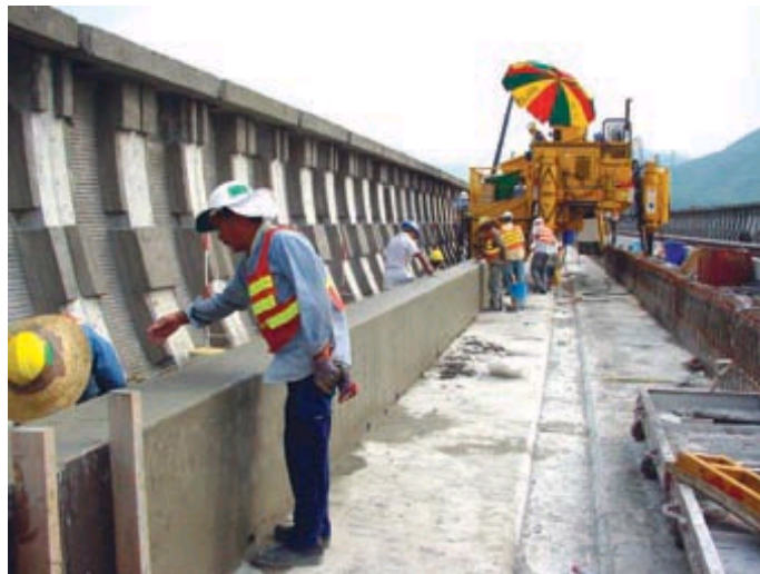
中国路面施工技术（下）
