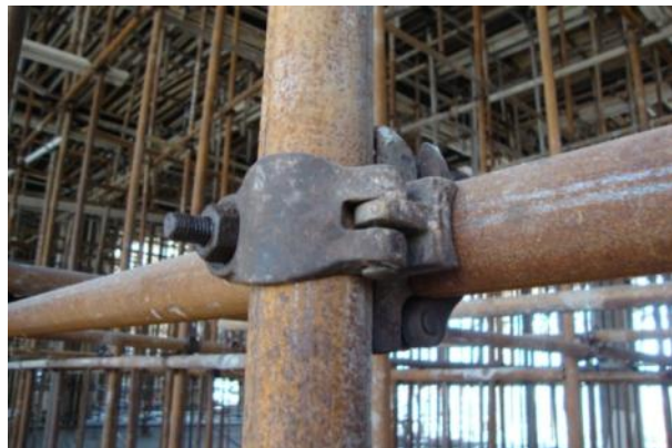
扣件式钢管支架节点
