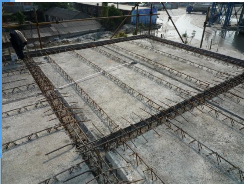
一次使用的预制混凝土叠合板
