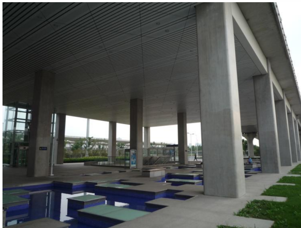
苏州园区城铁站的清水混凝土柱
