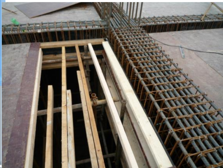
胶合板、木方和钢管组成的轻型模板
