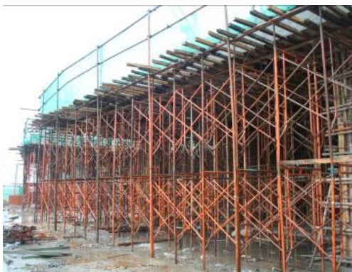
门式钢管脚手架
