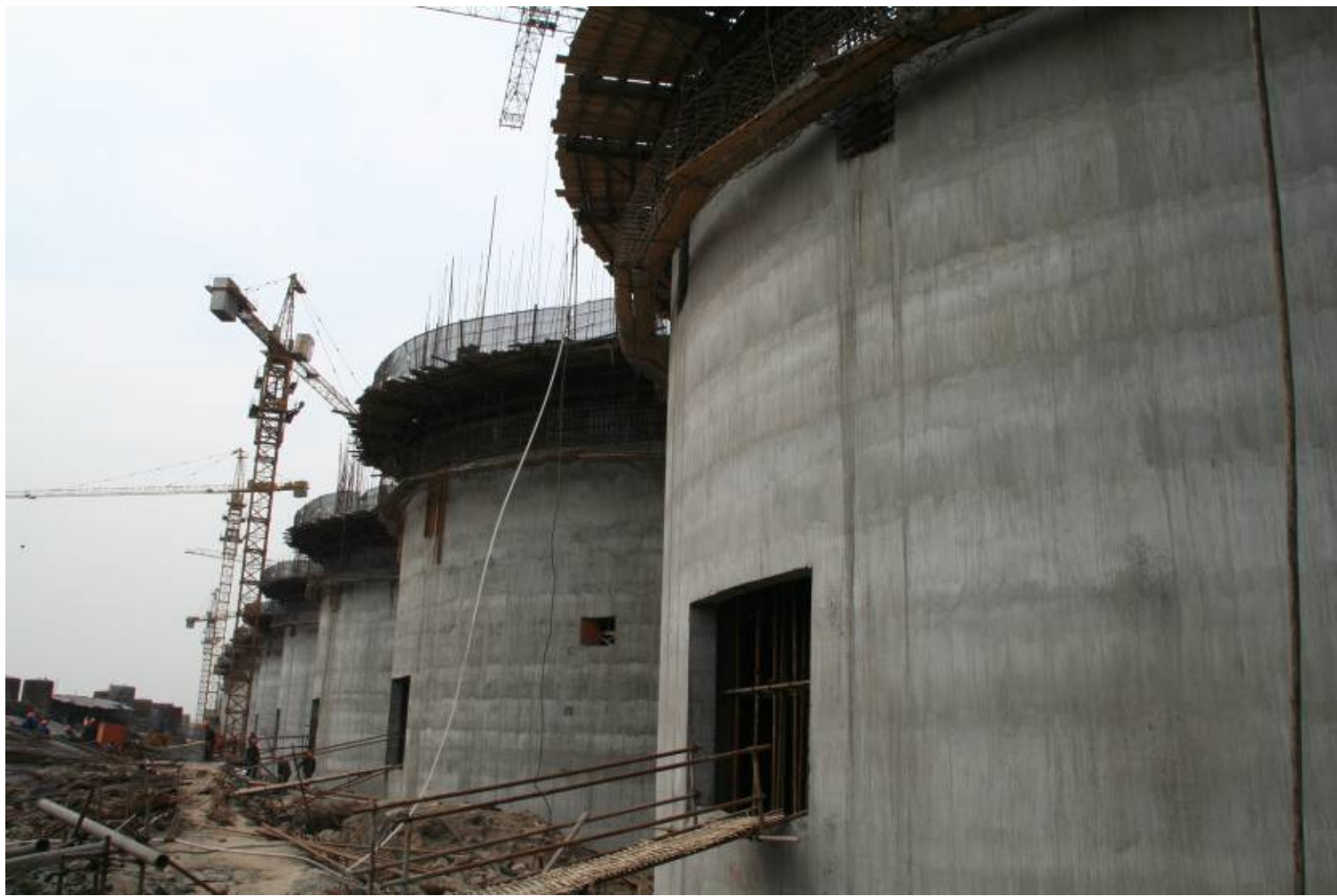
江苏沙钢集团储煤筒仓滑模施工
