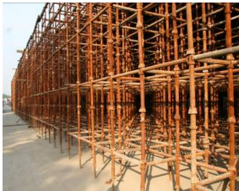
碗扣式钢管脚手架
