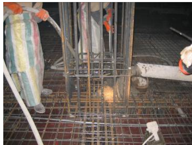
南京十四所研发大楼工程新浇混凝土侧压力的现场测试
