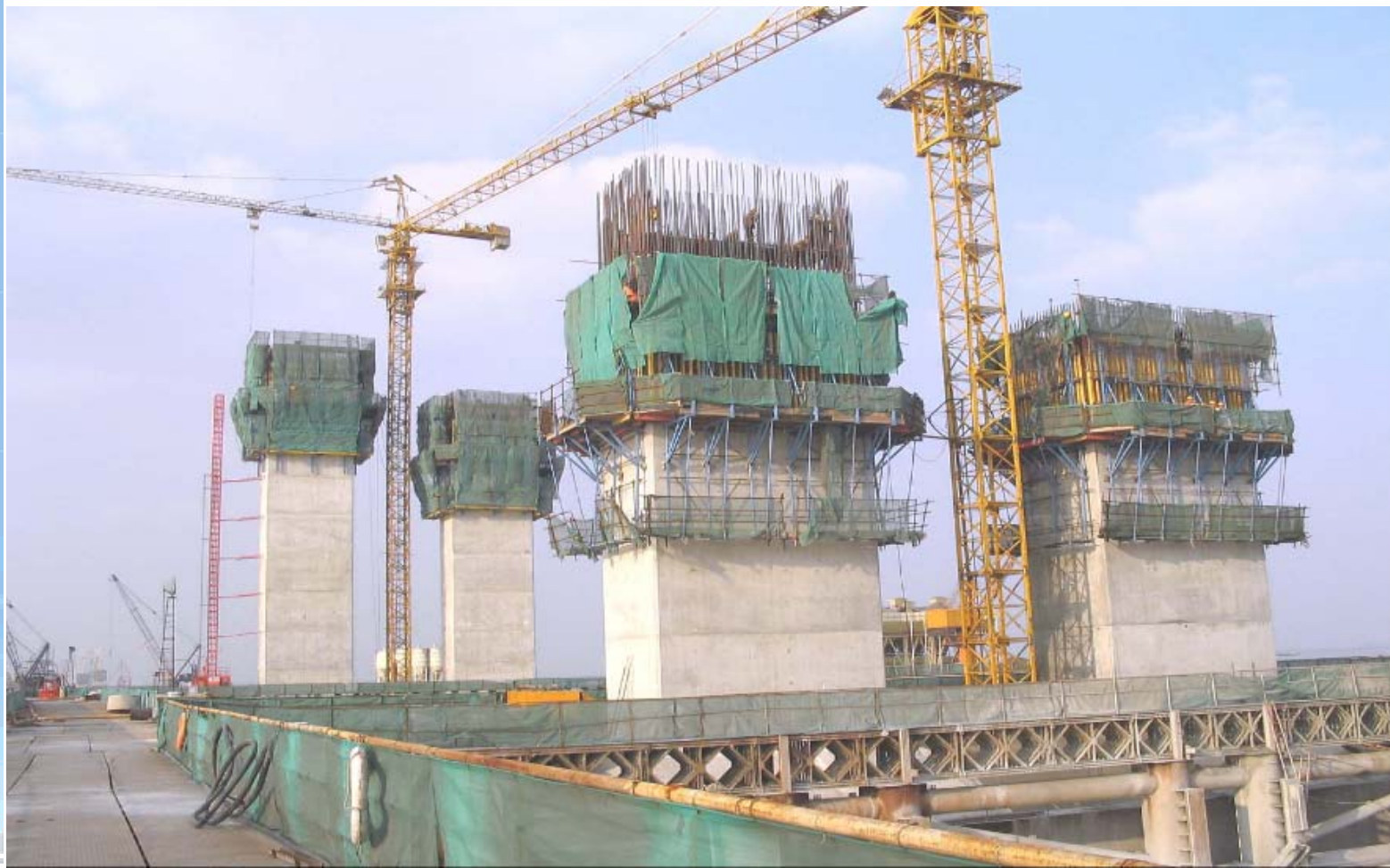
苏通大桥桥墩施工爬升模板
