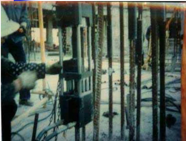
冷压套筒连接最初采用轴向冷挤压连接技术，与预应力施工中的挤压锚的挤压类同。
