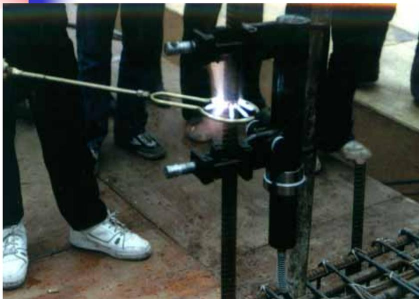
用强焰对钢筋端面加热后，集中用中炎加热，使钢筋连接的两端面加热至热塑状态。
