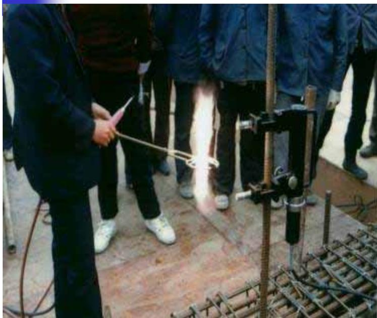
将夹钳夹住上、下钢筋端部，点燃焊炬。
