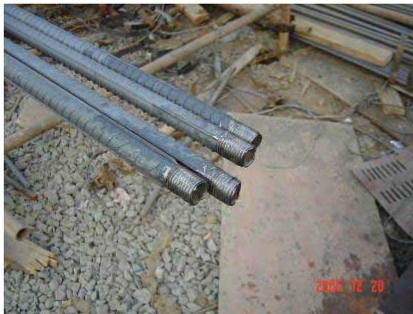
车削锥螺纹套筒连接最初采用较多，由于连接部位强度与母材不等强，最近被滚压锥螺纹、滚压或镦粗直螺纹连接方法替代。
