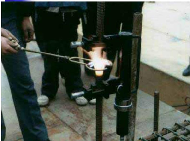
边加压边加热，两钢筋连接端面紧密接触在一起，金属原子互相扩散，形成有效的连接。
