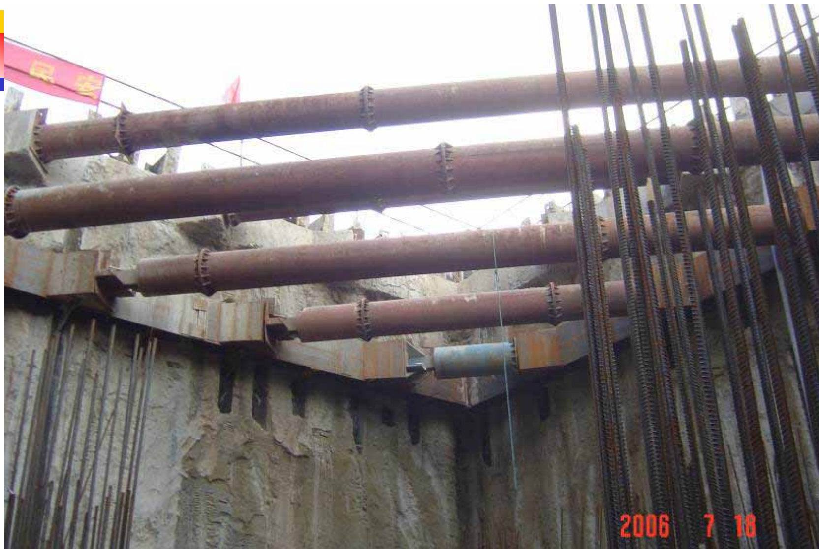
地铁站深基坑支护角撑
