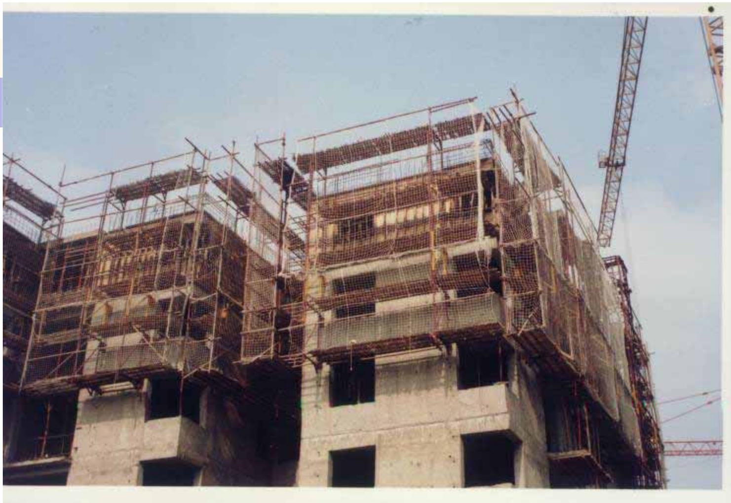
■ 高层住宅楼的阳台如何设计爬脚手架始终是头痛的问题。仪征化纤联合公司的高层住宅楼阳台部分设计了吊拉导轨，爬架固定在导轨上作升降。
