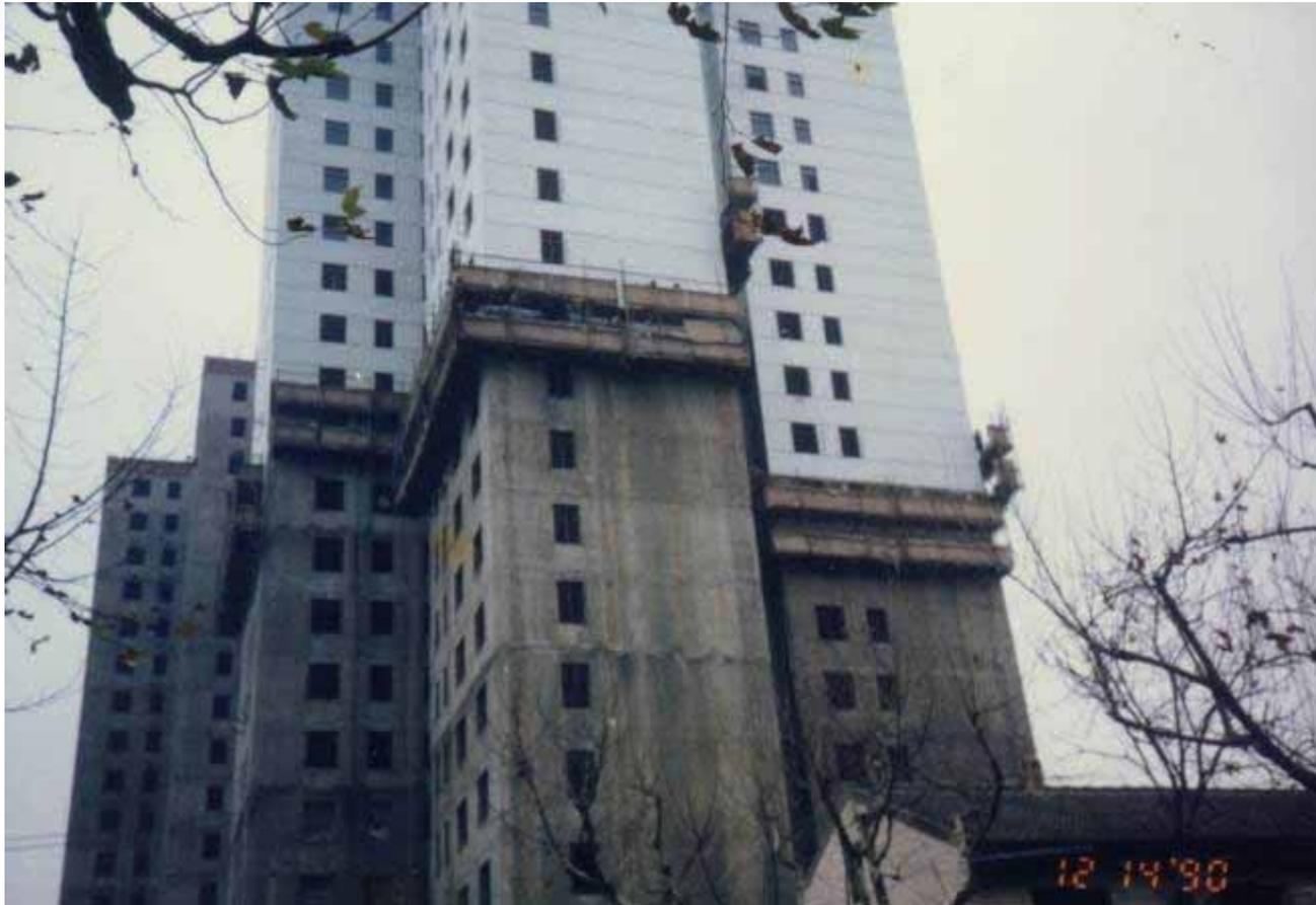
滑轨式升降脚手架由南通七建设计，高度为一个楼层
