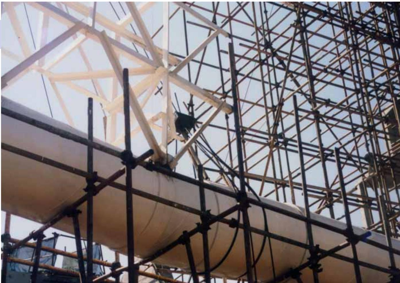
提升中，一端固定于柱的安全索始终将内环梁拉住，建立了防止突发连续倒塌的最后一道防线。
