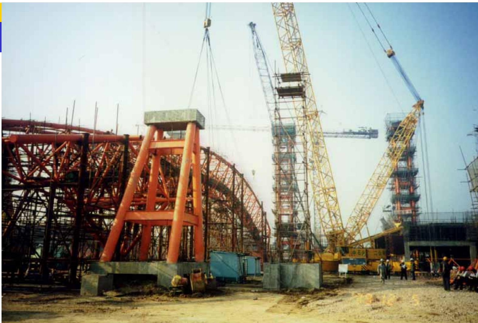
**吊机在跨内就位，直接影响该跨的主体结构施工，影响总工期。**
