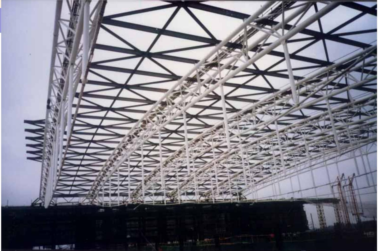
钢屋盖的安装方法采用累计滑移法，逐榀拼装，吊运至屋盖顶端，安装两榀钢拱架间的水平撑后，累计滑移。
