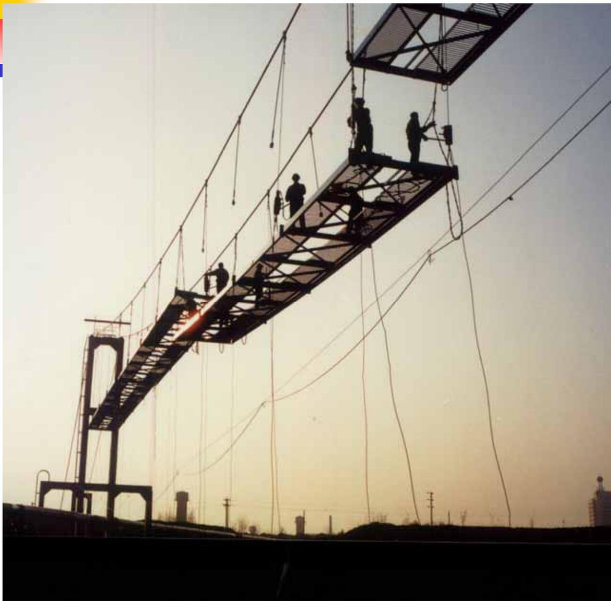
应用：将幕墙安装脚手架的方法移植到河面上钢桁架桥面板的安装，取得了成功。
