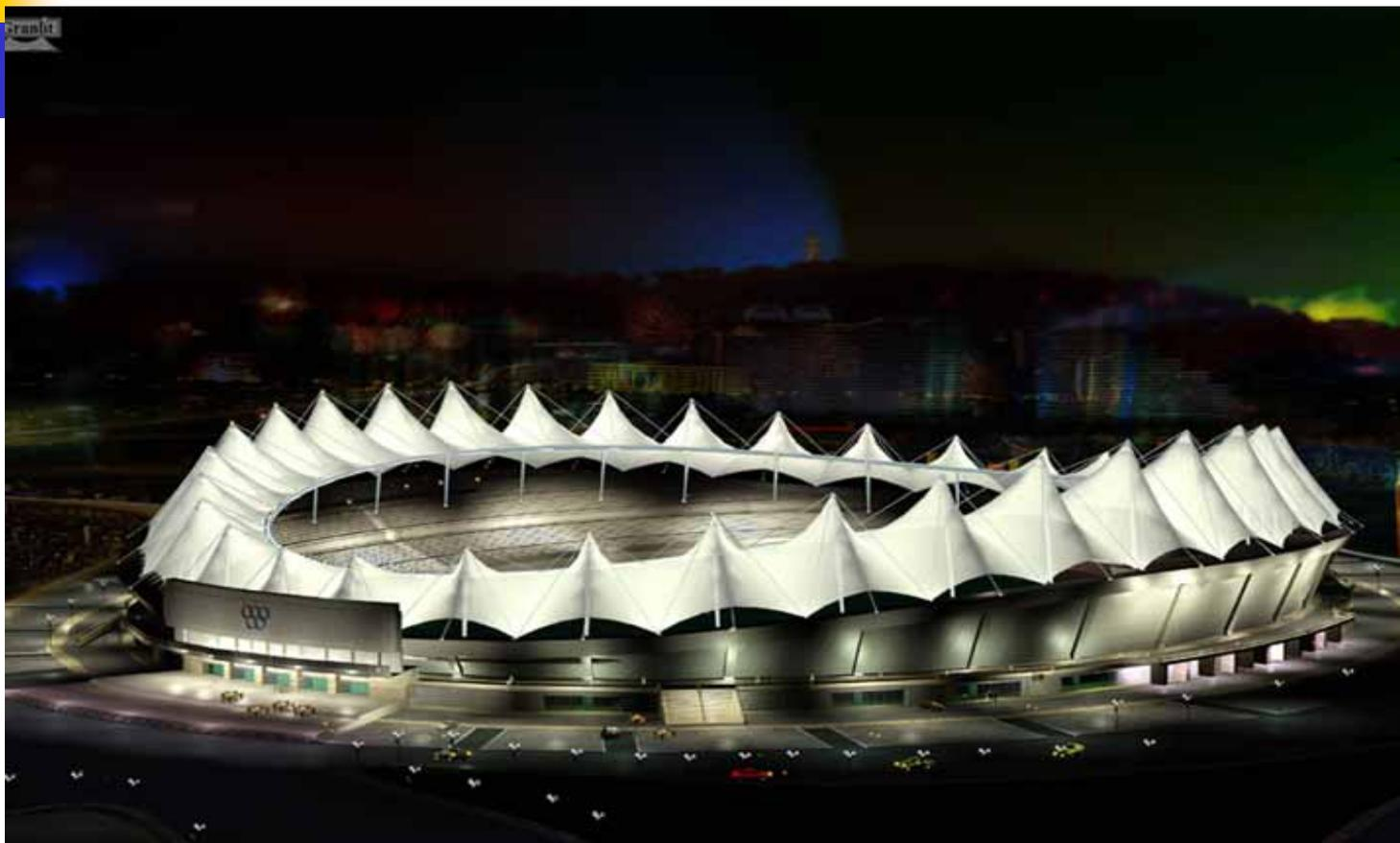
威海体育场采用张拉膜结构，其内环梁为一长轴205m，短轴143m，短轴方向高，长轴方向低，呈马鞍面的钢管结构劲性环梁，钢管为  $950 \times 20$ ，由前后结构索吊在34根钢立柱上，形成稳定结构。内环梁的安装采用整体提升方法。
