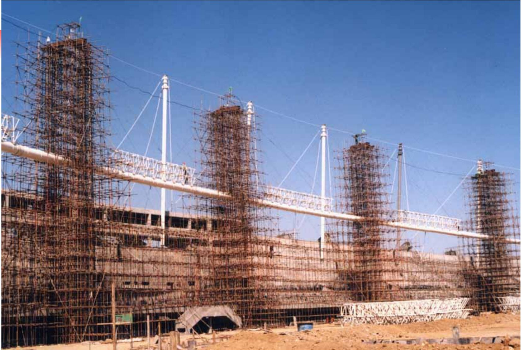
试提升100mm后，对提升架体做全面检查，作必要的加固，静载一夜后，连续提升。图为提升8m高度。
