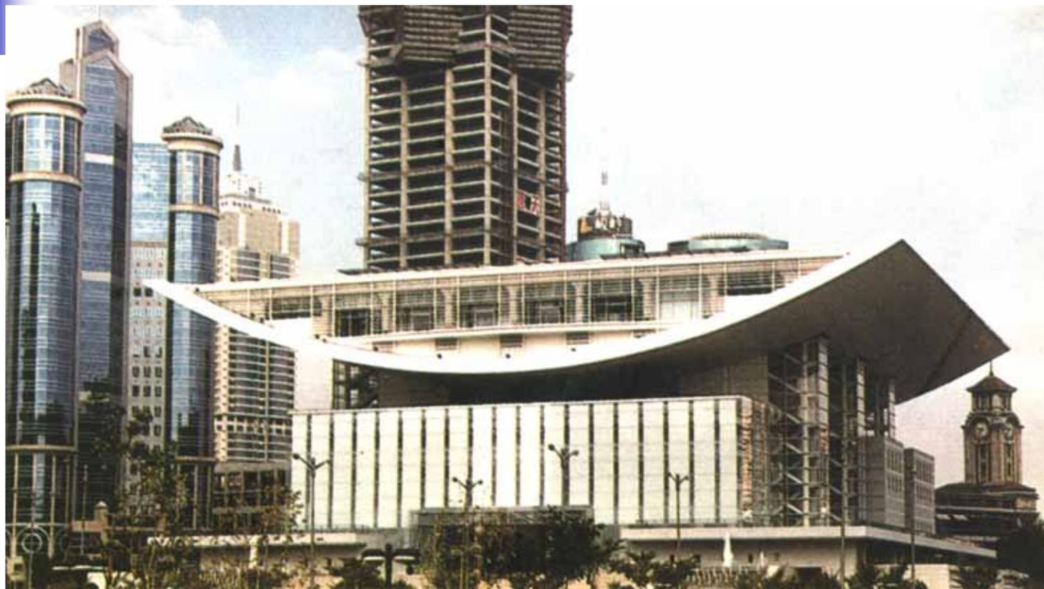
上海大剧院的屋盖采用钢结构的形式，整个屋盖长100米，宽90米，高11.4米，重6075吨，呈月牙形上反拱。
