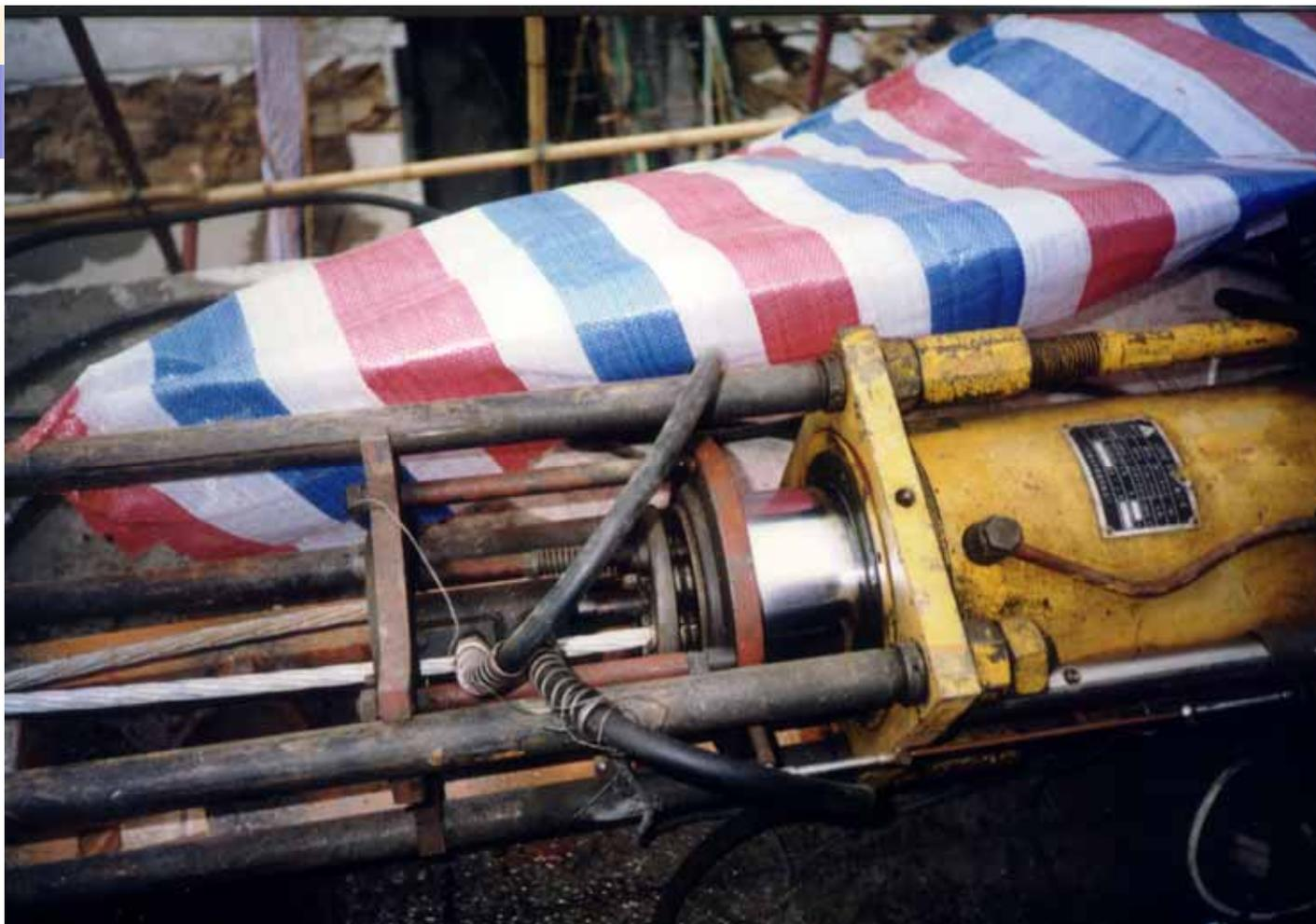
当千斤顶的前工具锚松开时，后工具锚夹住钢绞线拖动屋架移动。在工具锚尾部有一小千斤顶，起到防止夹片松动滑丝的作用。
