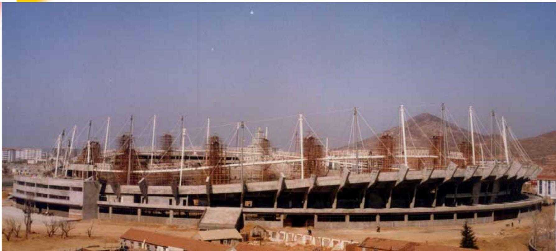
对劲性内环梁的安装 in 讨论方案时，考虑三种方法：即34根钢立柱柱顶的整体斜提升法；设计17个提升塔架的垂直整体提升法；搭设平均高度达25m的胎架高空安装法。采用的实际方法为用扣件钢管搭设提升架的垂直提升法。
