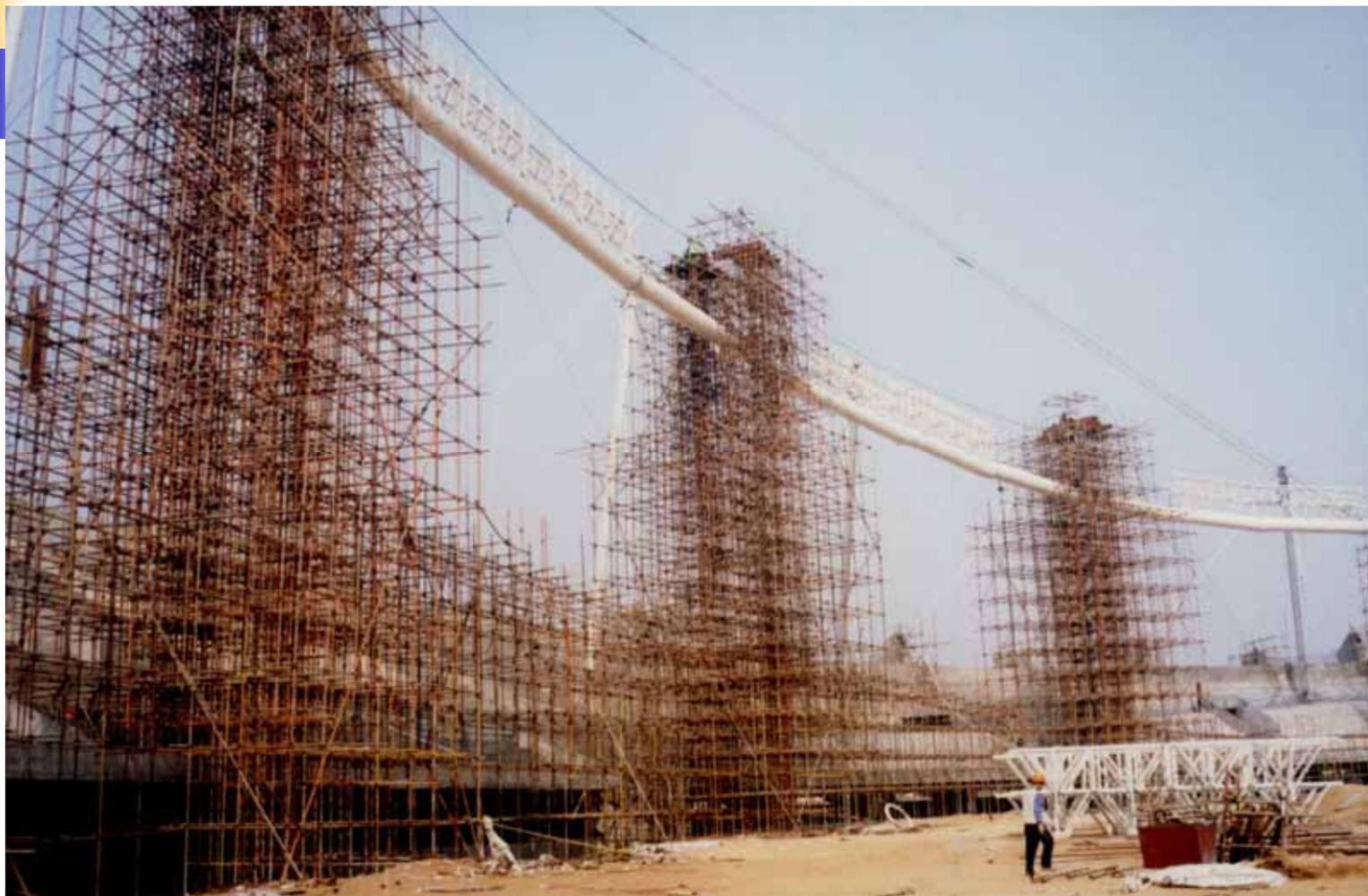
周长500m，总重约370t的劲性环梁需提升16m，由17个提升点，6台油泵同步提升。图为提升至14m高度。
