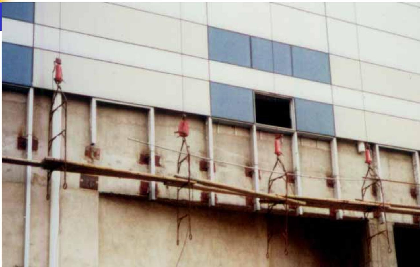
启发：徐州某医院的铝板幕墙的安装脚手架采用手扳葫芦沿钢丝绳自升降的方法。
