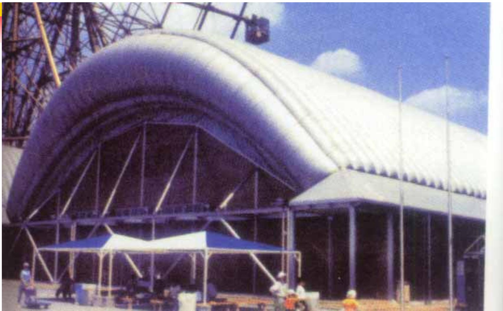
■ 气撑式膜建筑，依靠送风系统向室内充气，顶升膜面构成屋盖空间。
