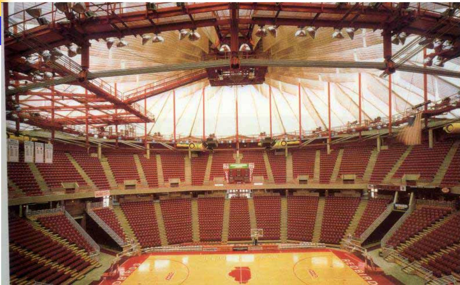
■体育场的屋顶为半透明和保温的悬索膜顶。伞壮的折顶形式通过24个飞杆将脊索撑起而形成峰顶，拉直的谷索形成峰谷。
