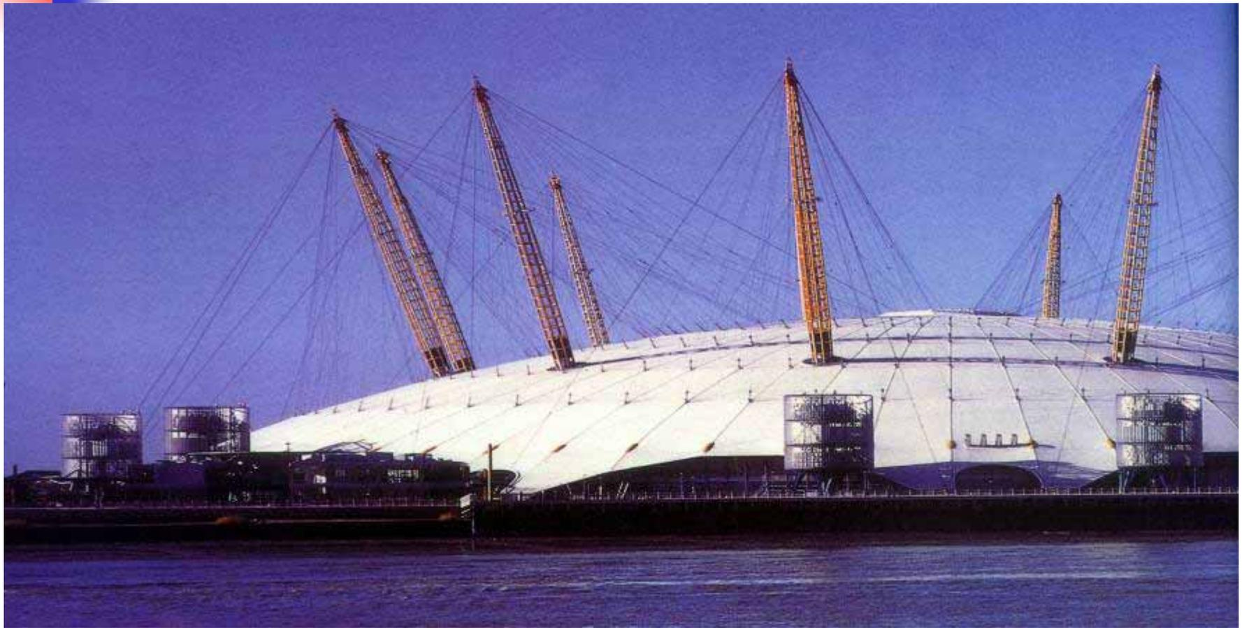
■英国格林威治千年穹顶。穹顶周长1km，直径365m，中心高度50m，它由超过70km的钢索悬吊在12根100m高的钢桅杆上。
