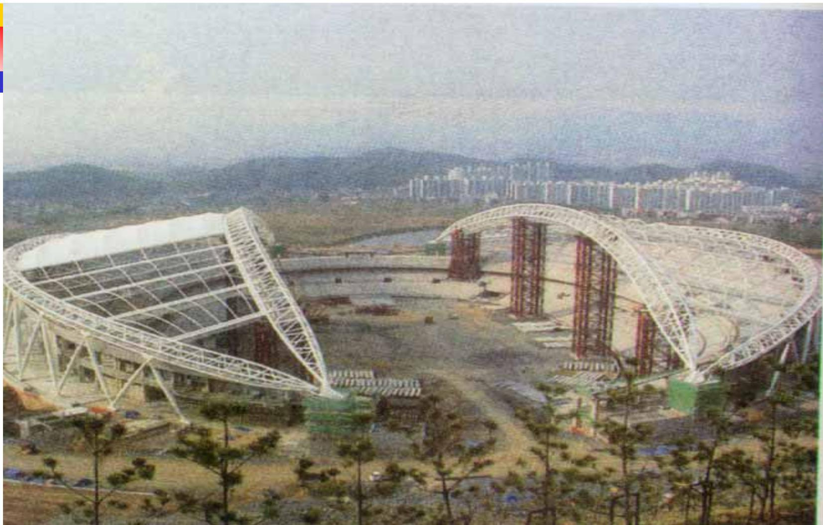
■ 屋顶由拱状钢屋架及24个PTEF膜结构组成。拱跨度273m，高28.7m，拱截面6m见方钢管桁架。
