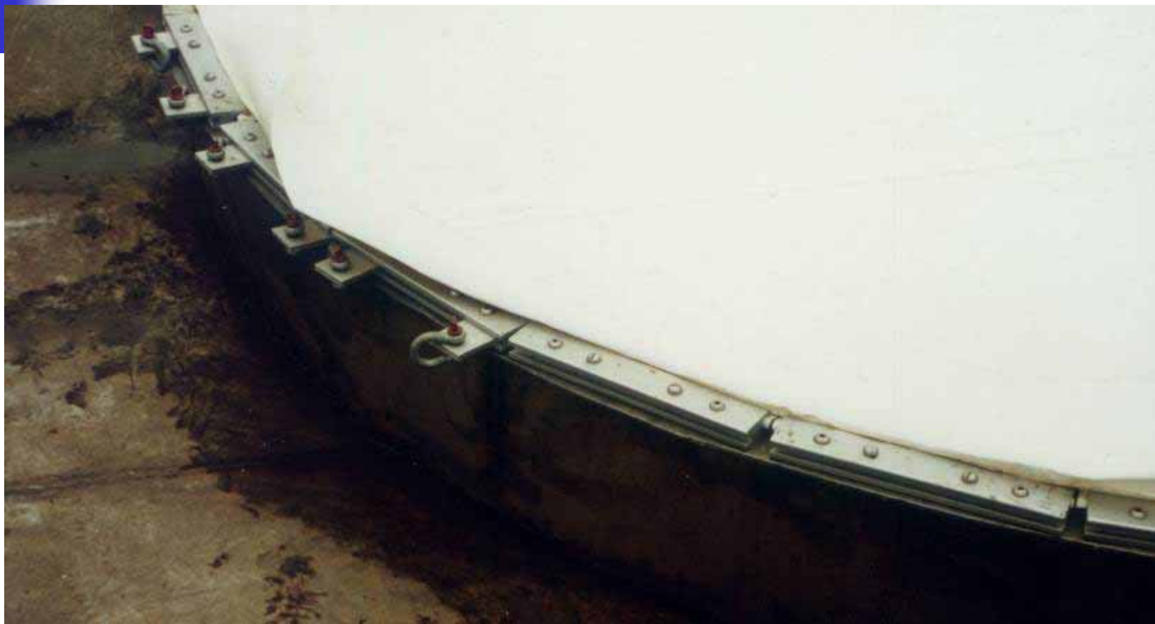
膜边缘的牵拉装置。
