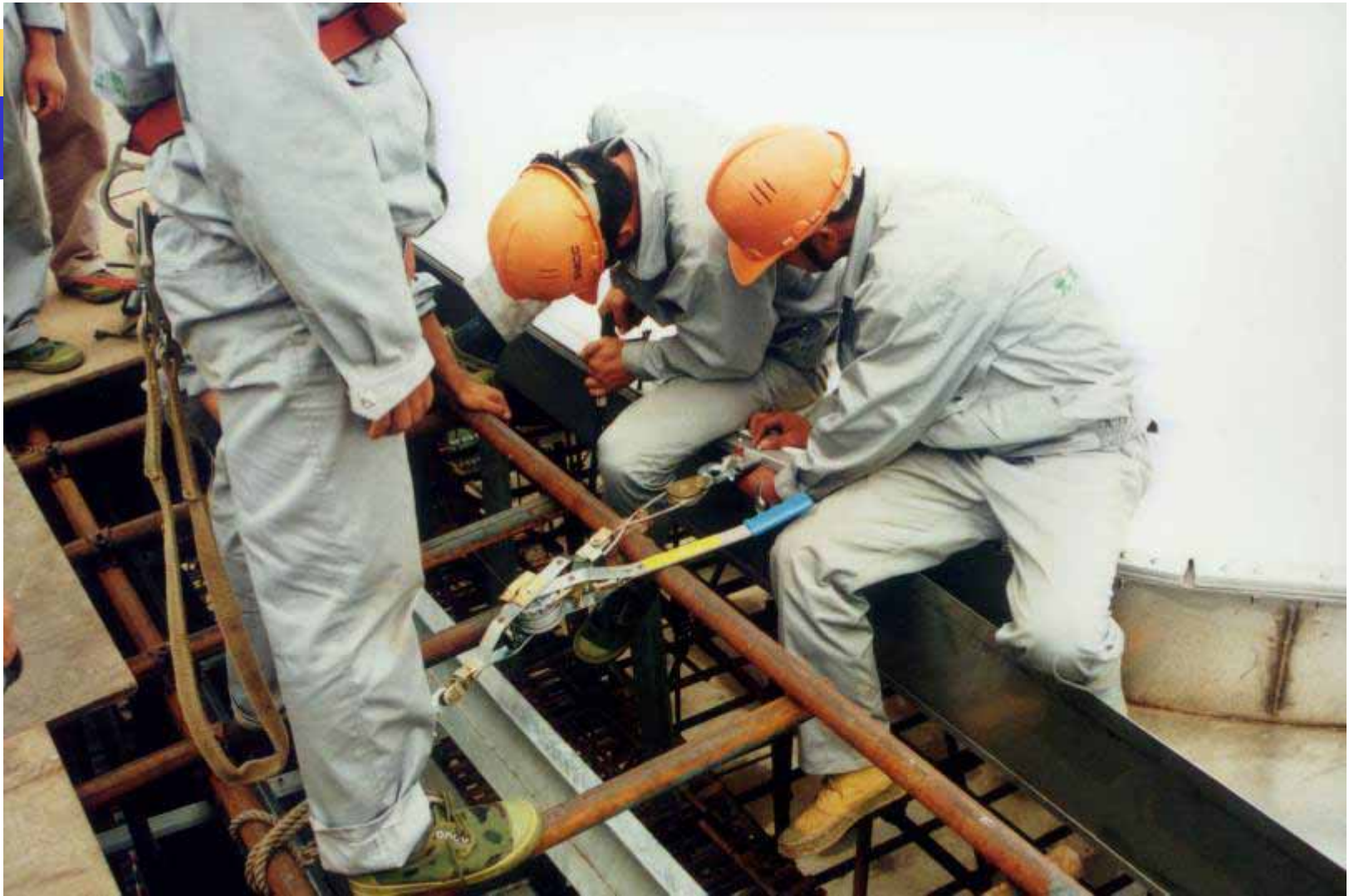
工人在牵拉膜，进行膜面安装。
