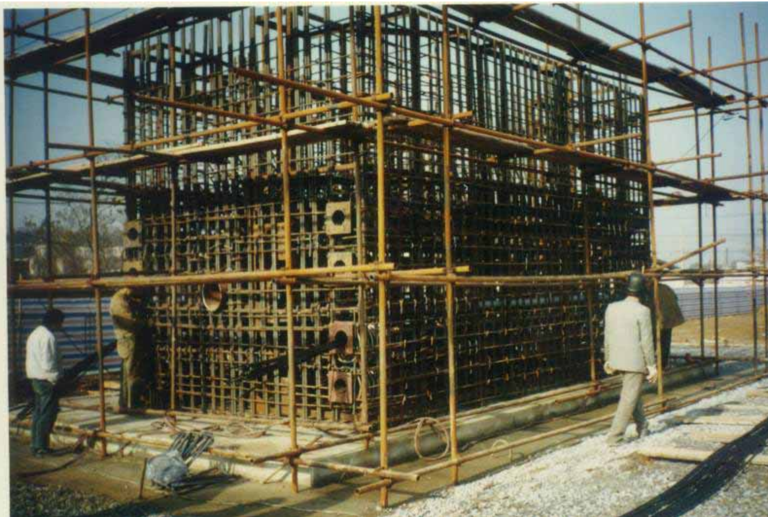
二桥的中塔柱截面尺寸 7.5 \times 4.5\text{m} ，图为桥塔上塔柱的1：1模型现场试验。
