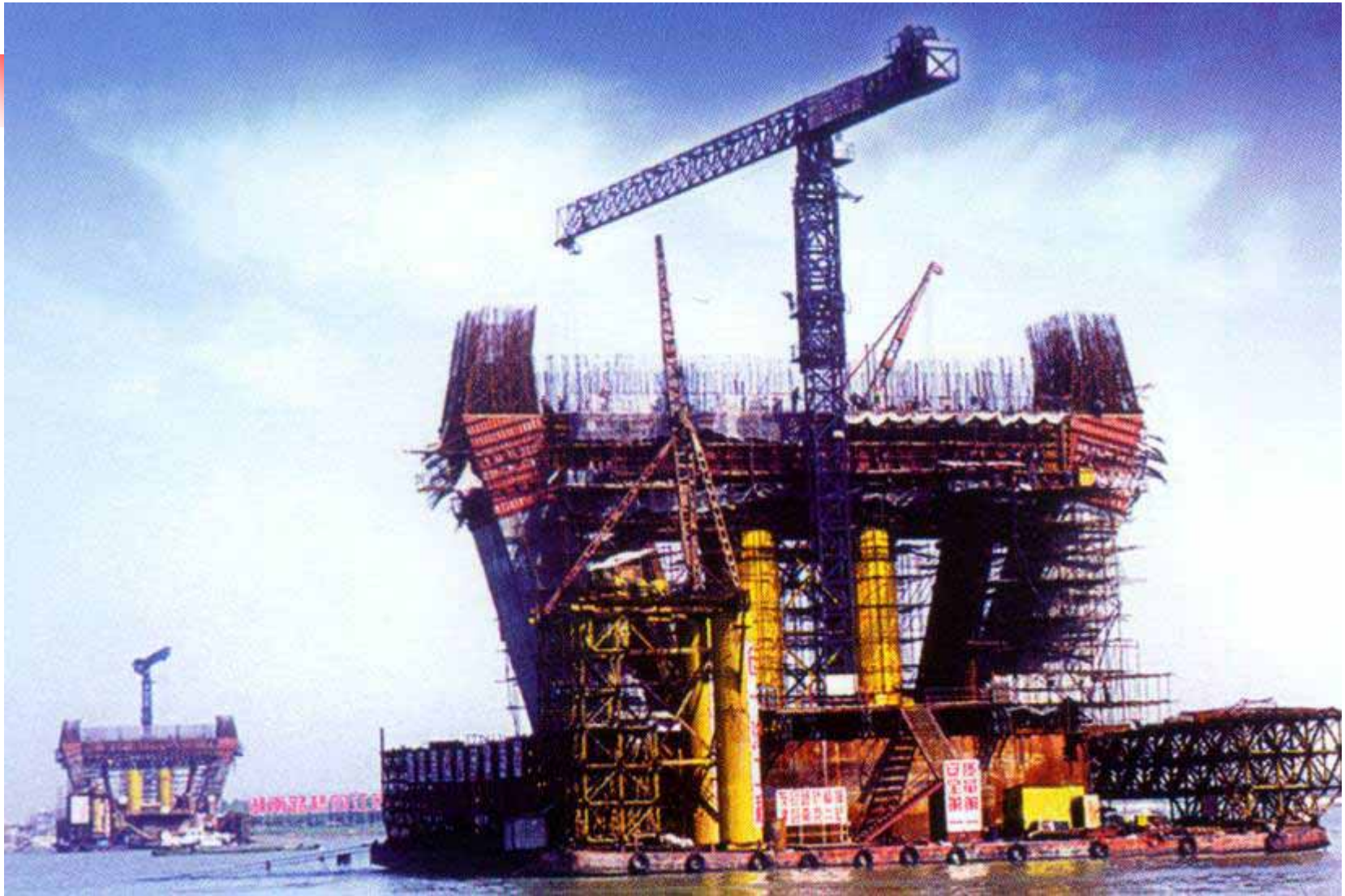
索塔下横梁施工，下横梁长度46.6m，截面尺寸7.56 × 8.0m。
