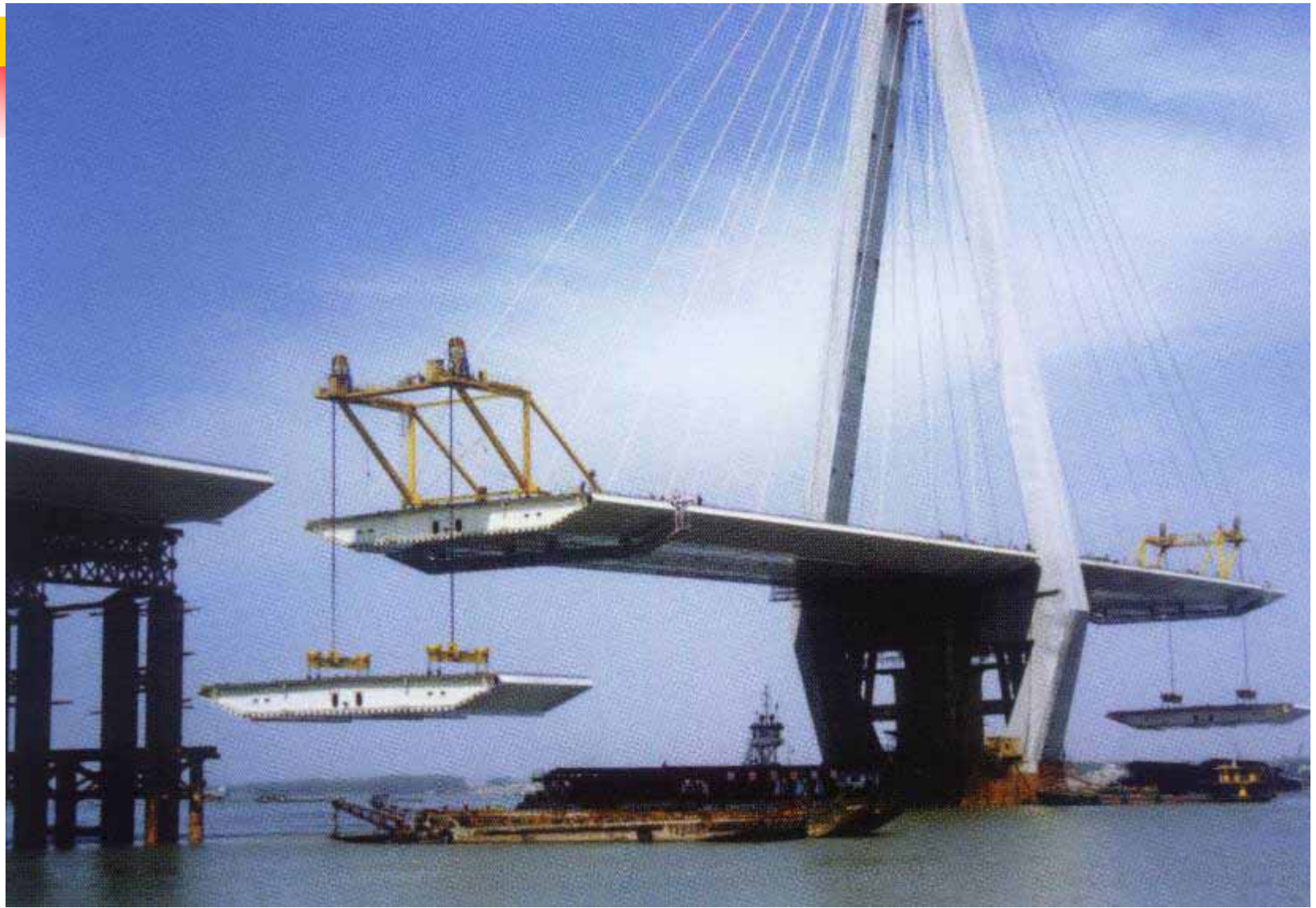
钢箱梁江上起吊，起吊高度20m，每行程200mm。
