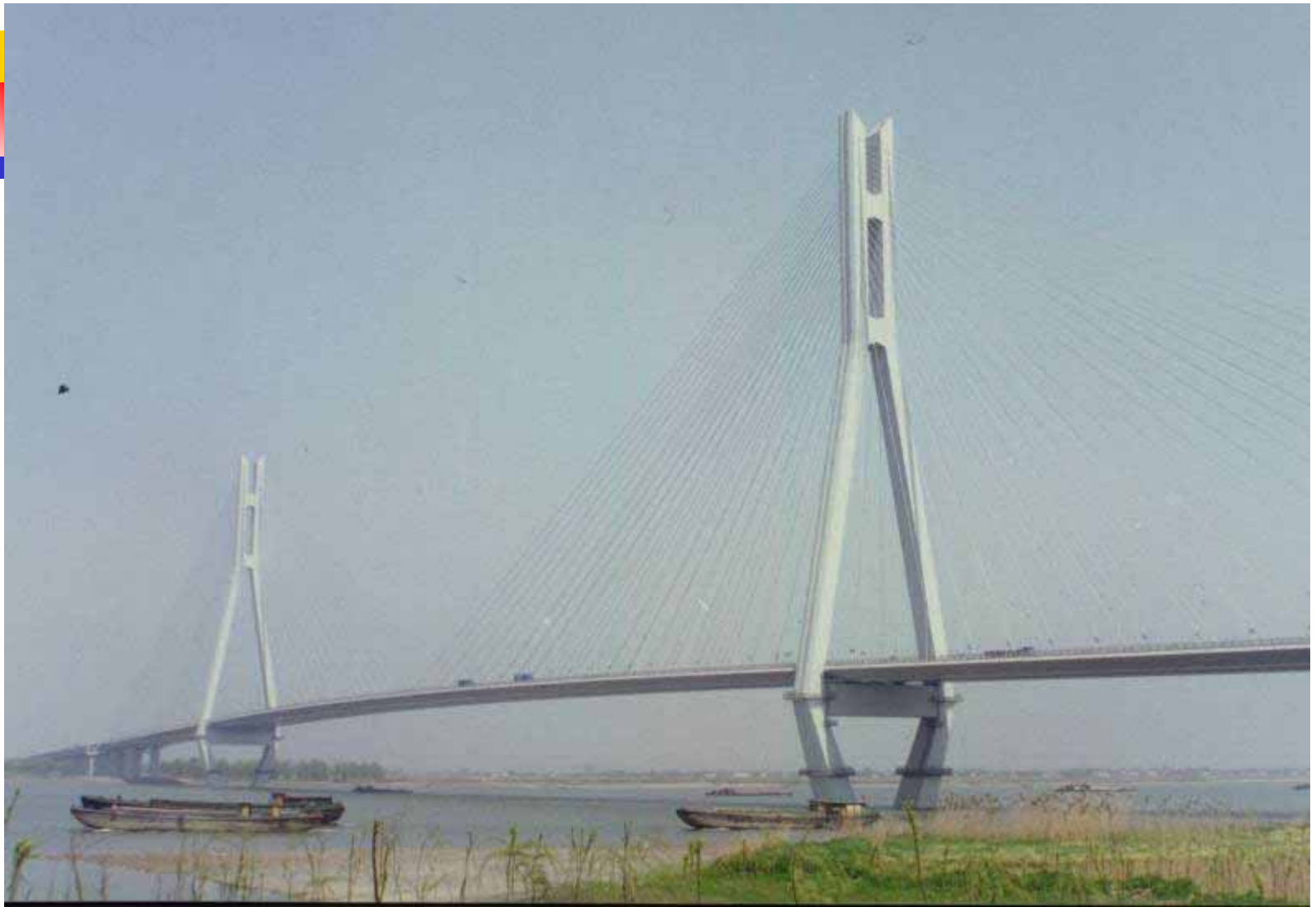
南京长江二桥斜拉桥主跨628m，边跨246.5m，索塔高195.41m。
