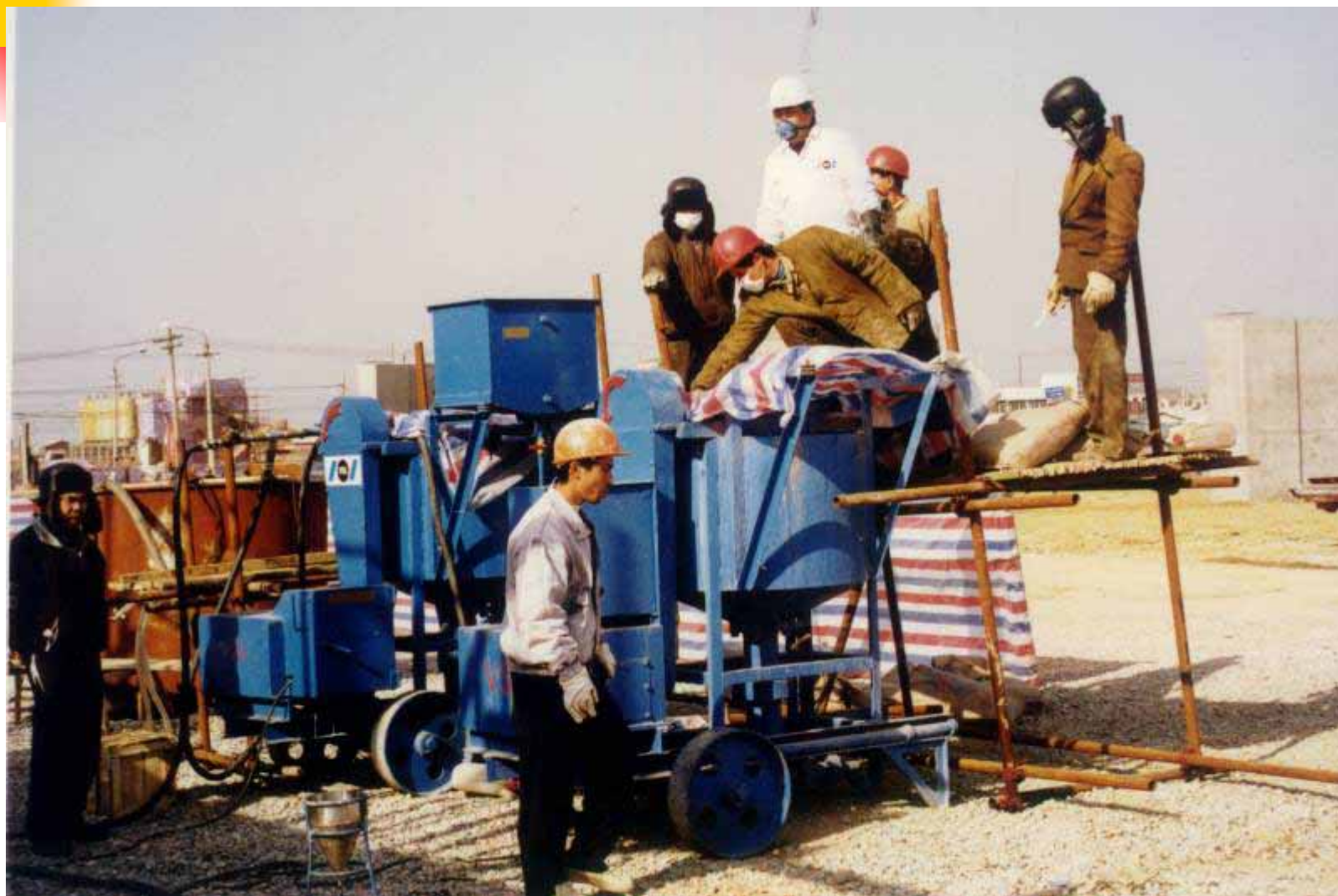
工人在准备搅拌水泥浆。
