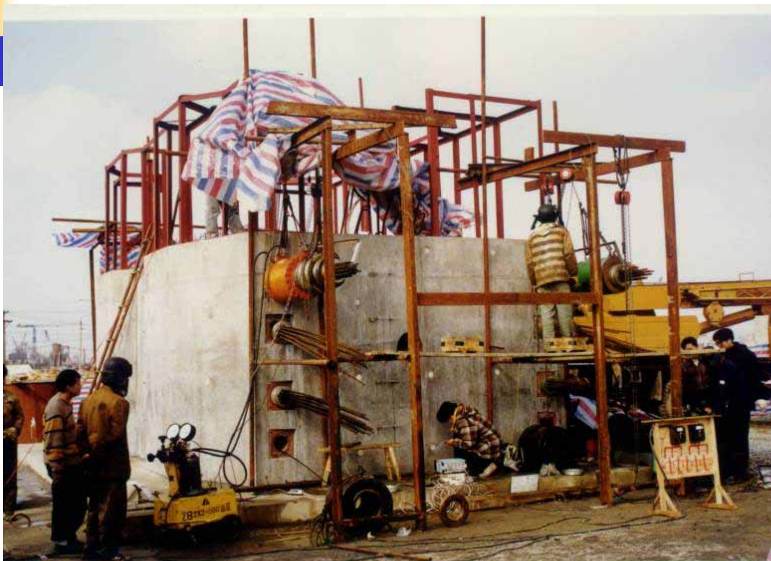
桥塔的上塔柱拉索区配置了92道U形预应力筋，弯曲半径1.55。图为千斤顶进行张拉。
