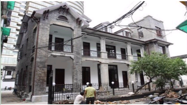
杭州市邮电路16号历史建筑加固再利用工程
