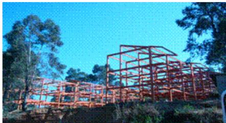
图3 H型钢低层钢结构住宅
