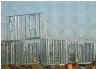
图2 C型钢低层钢结构住宅
