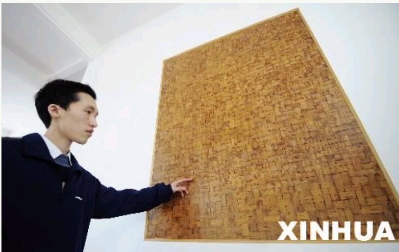
湖南大学土木工程学院学生在介绍抗震环保竹住宅内部的竹结构墙体（3月31日摄）
