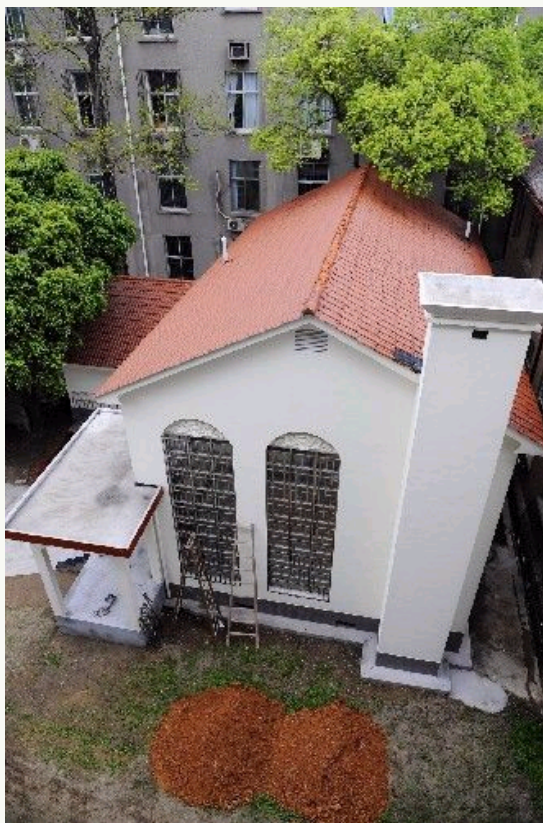
建于湖南大学土木工程学院院内的抗震环保竹结构别墅（3月31日摄）
