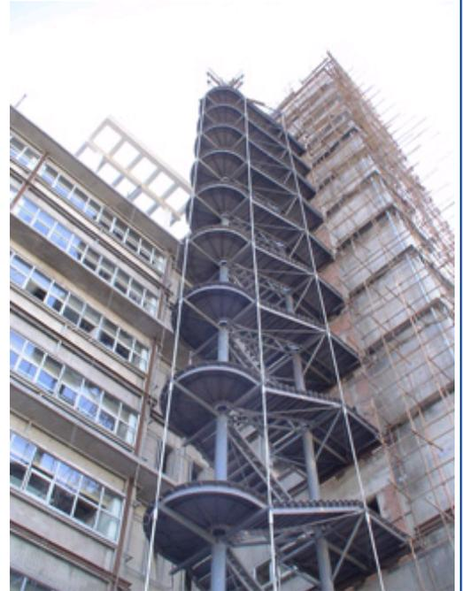
由于该结构为国内首创，既要保证结构的美观，又要保证结构的安全性，因此设计及施工中必须周密考虑。为确保结构的稳定性、美观性，针对结构自身的特点，项目组主要采取了以下相应措施：外侧钢拉杆采用特殊材料、特殊工艺制作的高强钢棒；预应力施工前模拟计算出各种工况下钢棒的受力状态，从而保证各阶段结构的安全、施工的准确；该工程施工采用上端为张拉端，下端为固定端的张拉方法，张拉过程中要确保对称张拉施工；为保证结构变形在允许范围内，施工方案严格按照分析计算的结果进行，采取多级张拉的方式，每一根高强钢棒分
