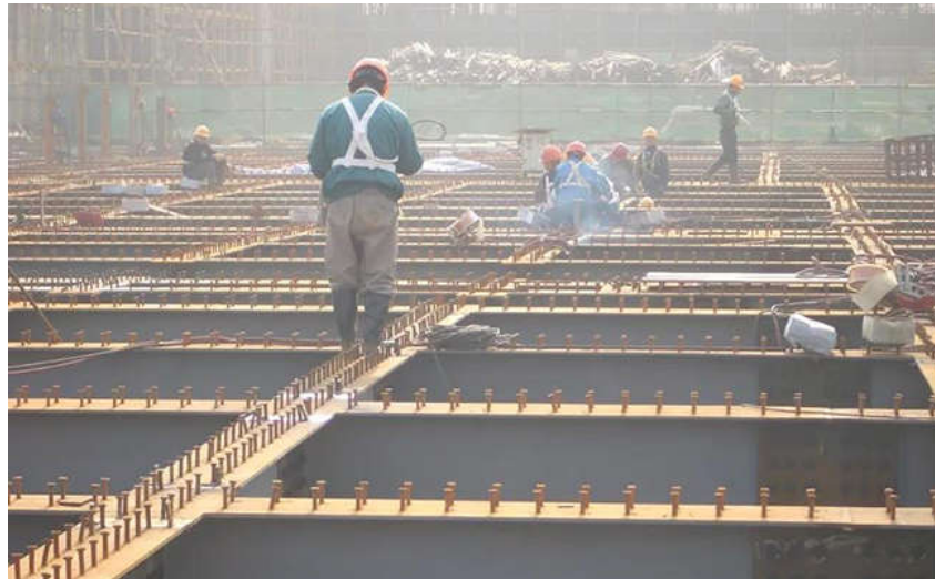
新型大跨组合楼盖结构应用于武昌站改造工程
