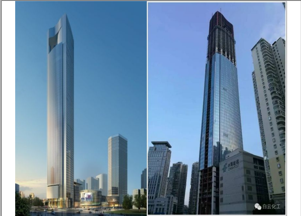
厦门国际中心(世界使用粘滞阻尼墙的最高建筑, 经历了2016超强台风莫兰蒂的考验)
